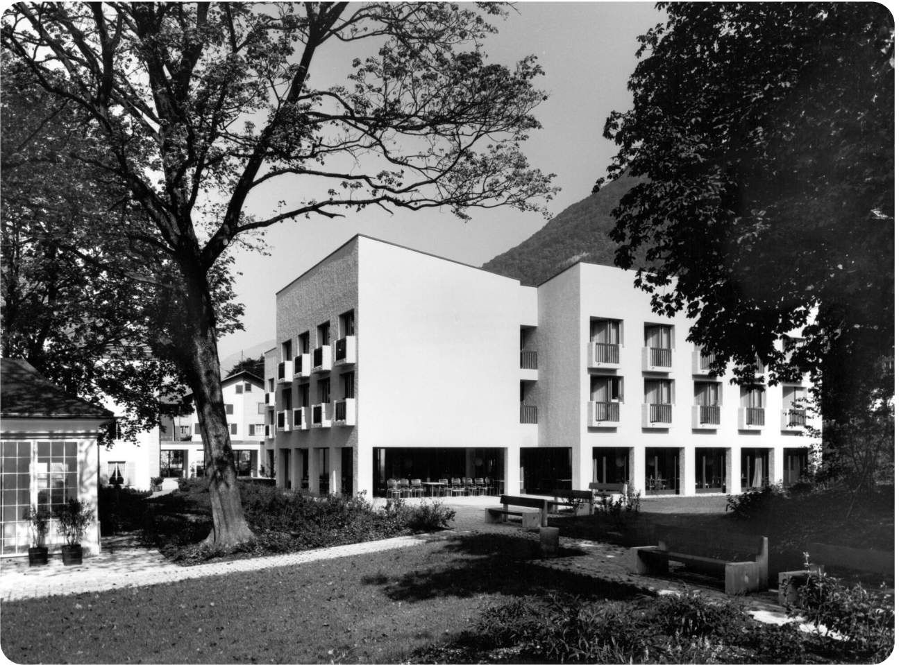
Tilla Theus: Altersheim Hof mit Alterswohnungen in Mollis, 1970-1973, Neu- und Umbau.
